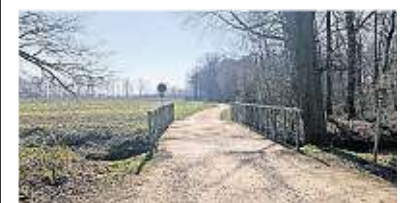
Ab dem 21. März wird die Brücke erneuert.
